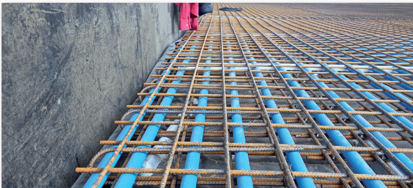
Orurowanie PE przygotowane do betonowania
