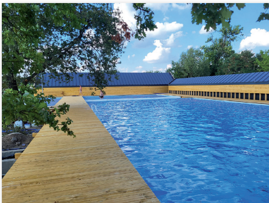
Zadbanie o bezpieczeństwo na obiekcie zaczyna się na etapie opracowania dokumentacji projektowej, gdzie bardzo duży nacisk należy położyć na minimalizowanie stref martwych pól nadzoru obsługi, doboru właściwych materiałów budowlanych i wykończeniowych wpływających na czytelność komunikacji oraz ograniczenie negatywnych zdarzeń jak np. poślizgnięcia
