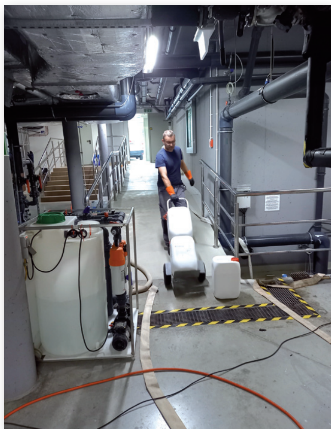
Proces oksydacyjnej regeneracji złoża w filtrach
