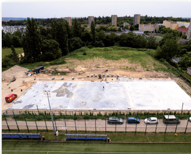
Podłoże wykonano ze specjalnej płyty betonowej z mieszanki wibrowanej mechanicznie, wyjątkowo odpornej na obciążenia dynamiczne i ściskanie
