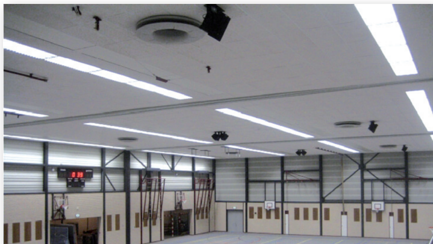
Rekuperatory dachowe Turborex TX 3100A są przeznaczone do wentylacji hal sportowych i pomieszczeń o dużej kubaturze
