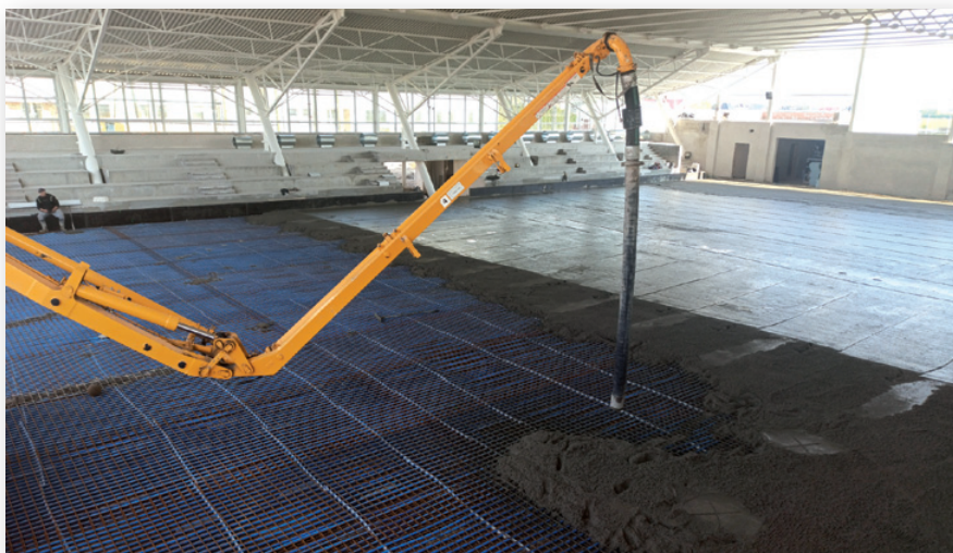
Montaż instalacji mroźniowej na krytym lodowisku w Przasnyszu
