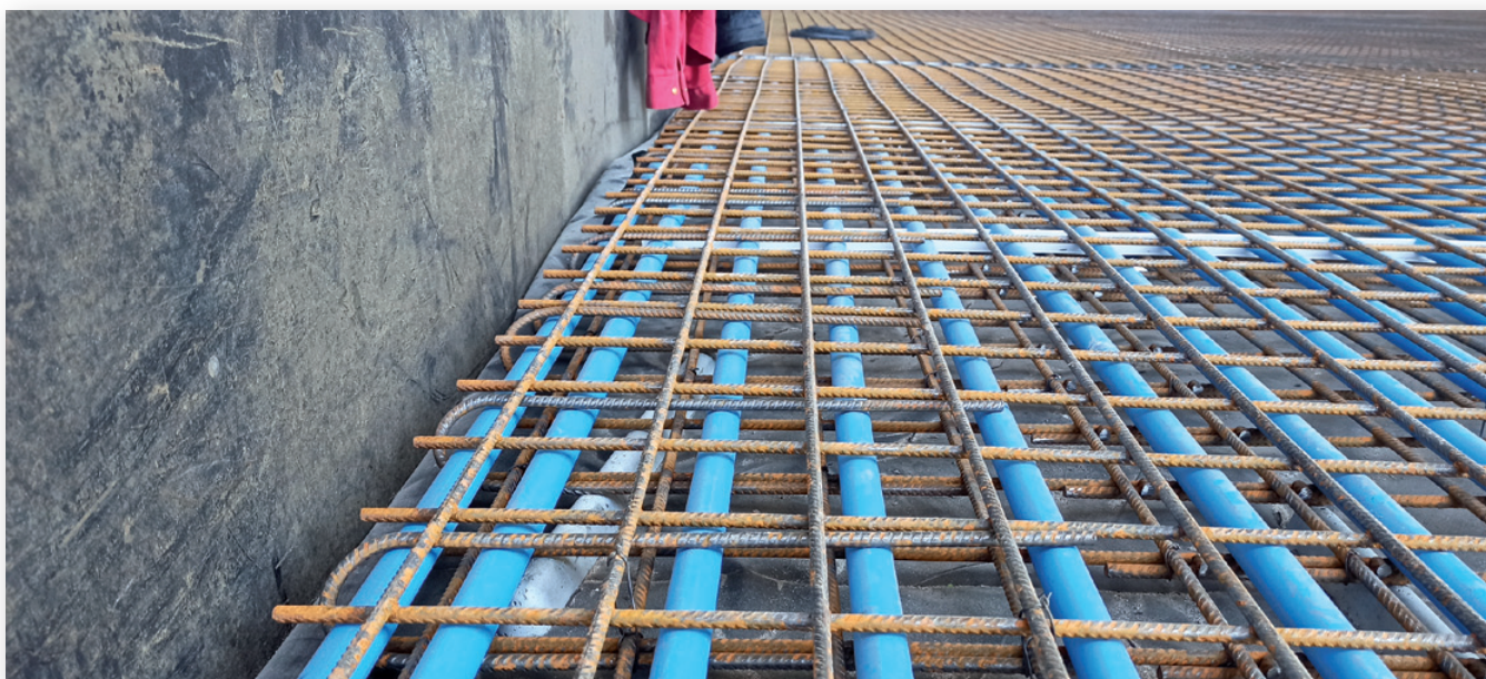
Orurowanie PE przygotowane do betonowania
